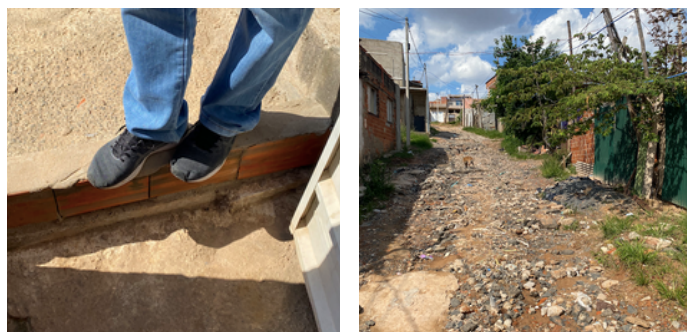
Figura 4: Estratégia para evitar alagamentos em residência (esquerda) e rua em situação precária após chuvas (direita)
