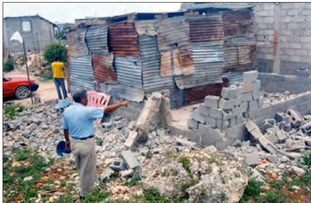
Picture 3: 2004. Rebuilding the rubble in el Barrio Valiente.
