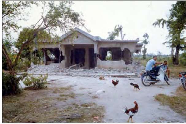
Picture 2: 2004. Demolition of a home in el Barrio Valiente.
