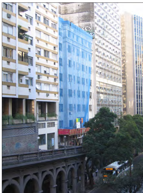
Imagen 6: 14 de julio de 2008, el edificio está siendo renovado.
