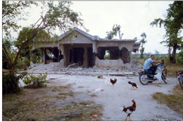
Imagen 2: 2004. Demolición de una casa en el Barrio Valiente.
