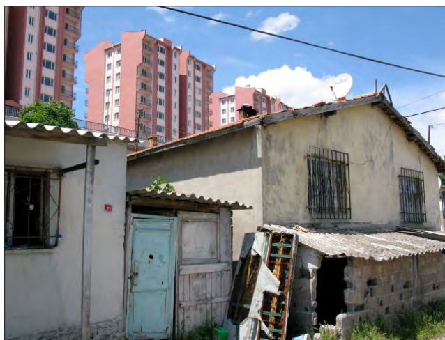
Imagen 7: Lo que queda de Kurtköy Gecekondu. Los bloques de vivienda en la parte de atrás fueron construidos sobre las casas demolidas. Todavía siguen desocupados.
