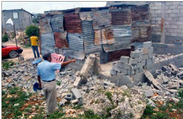
Imagen 3: 2004. Reconstrucción de escombros en Barrio Valiente.
