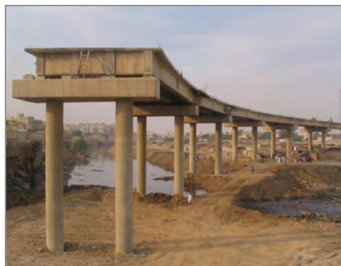
Imagen 4: La construcción de la LEW está en marcha.
