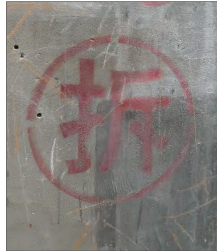
Imagen 6: el temido símbolo de una orden de demolición colocada sobre un edificio.
