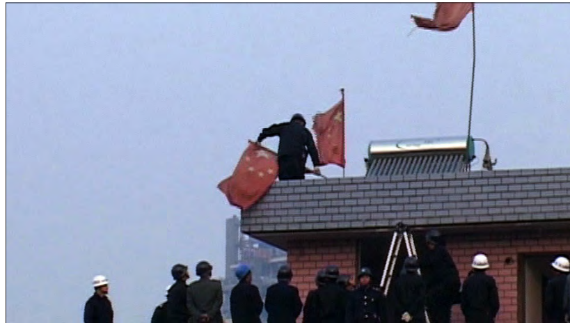
Imagen 8: La policía retira banderas que los residentes izaron en los techos de sus casas antes de la demolición. Esta imagen fue tomada de una película de video filmada por uno de los residentes
