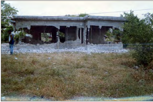
Imagen 1: 2004. Demolición de una casa en el Barrio Valiente.
