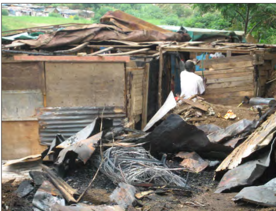
Imagen 3: enero de 2007, reconstrucción después del incendio de una choza en Kennedy Road.
