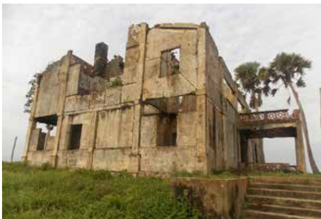
Photo 4: ancien Palais du Gouverneur à Sassandra Crédit photo : KIENON-KABORE, 2016
