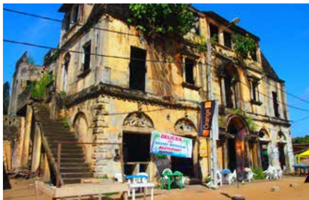
Figure 4: Bâtiment Ganamet (© Affoh Guenneguez, n.d).
